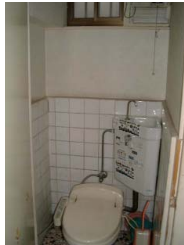
修繕前のトイレ
