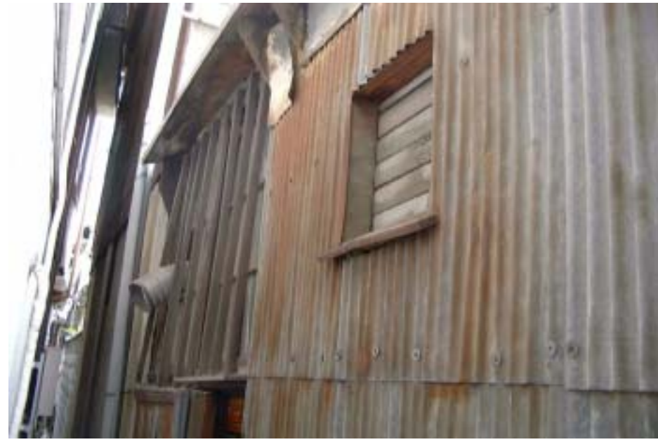
外壁も波型鉄板
