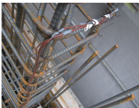
<写真7 鉄筋に設置した熱電対>
