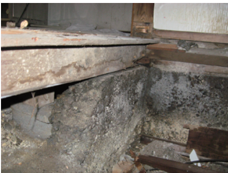
＜写真 6 解体中の様子＞
