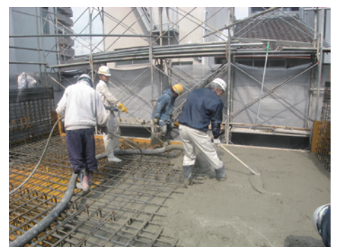
<写真13 コンクリート打設>
