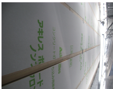
<写真15 断熱材施工>
