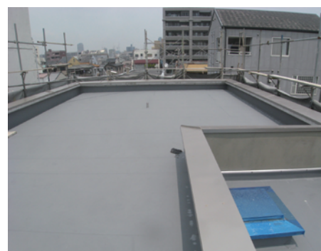
<写真16 屋上防水>
