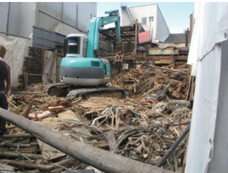
＜写真 5 解体中の様子＞
