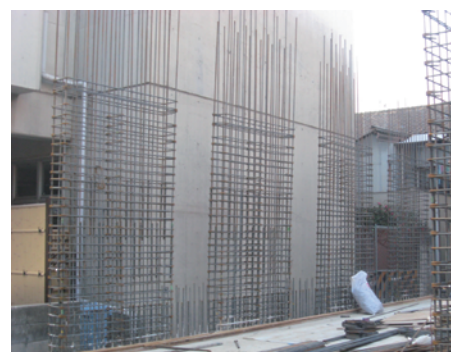
<写真12 柱の配筋>
