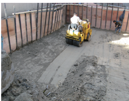
<写真10 地盤改良>
