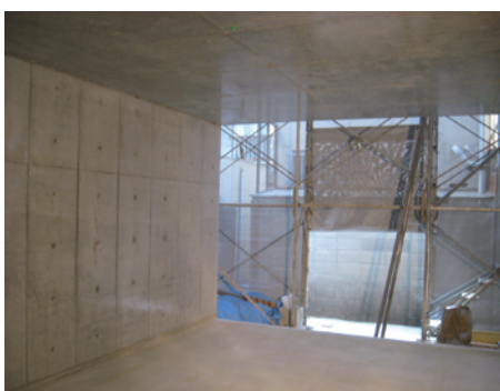
<写真14 型枠解体>
