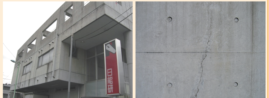
<写真9 外部にさらされ劣化したコンクリート建物>
